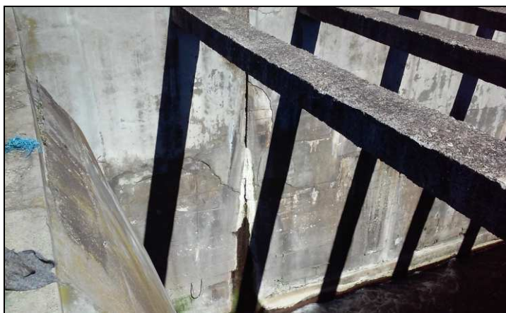
Starea initiala la momentul preluarii stavilarului
