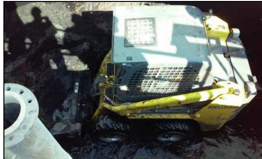
Actiune periodica de curatarea gratarelor, ce conduce la oprirea SEAU Glina pentru maxim 8 ore.
