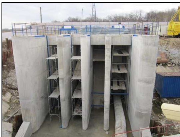
Stavilarul in timpul lucrarilor de etansare si reabilitare
