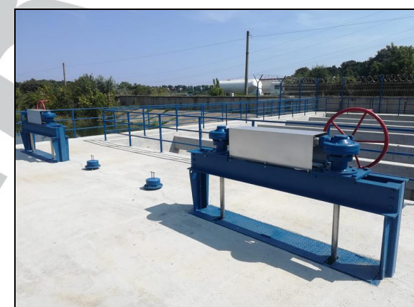
Stavilarul la finalizarea lucrarilor de etansare si reabilitare
