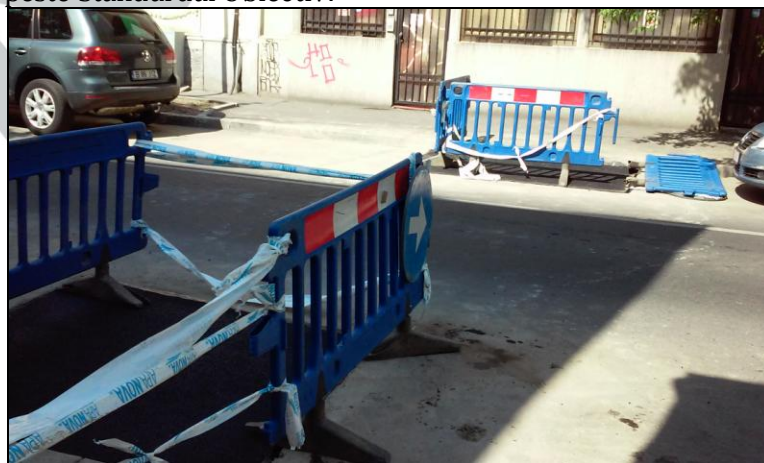
Refacere carosabil dupa interventia la rețeaua publică de distribuție apă potabilă
