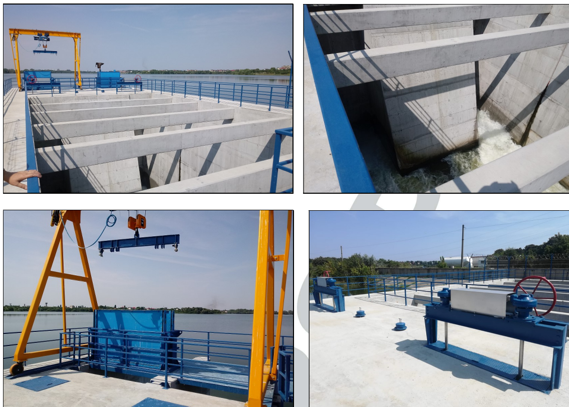
Stavilarul la finalizarea lucrarilor de etansare si reabilitare
